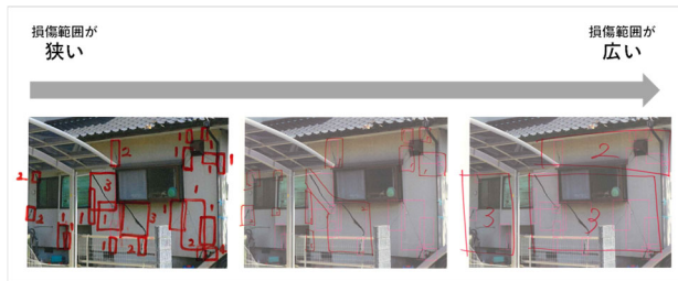
図6. 損傷箇所の囲い方の例
