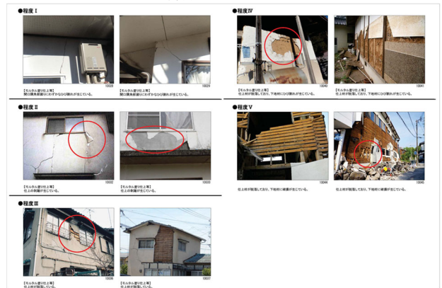
図1. 損傷程度の例示(外壁) 4)
