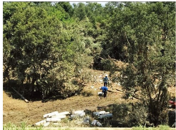
図1 平成30年西日本豪雨時の流出容器回収の様子 LPガス災害対策マニュアル第3次改定版参考資料より
